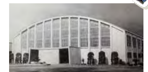
鉄骨、一部鉄筋コンクリートの体育館は当時大変めずらしかった
