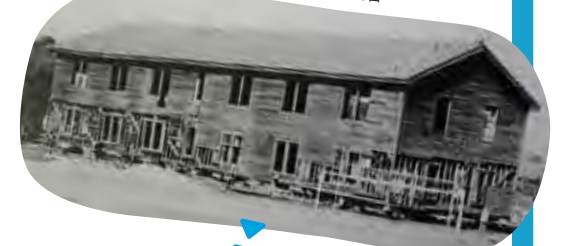
兵器庫として使用されていた木造建築の校舎
